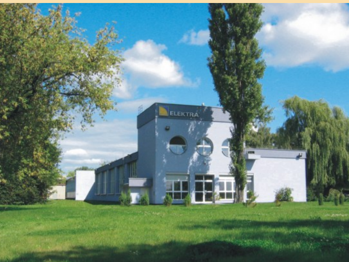
Centrum Dystrybucji oraz Zakład Produkcyjny
