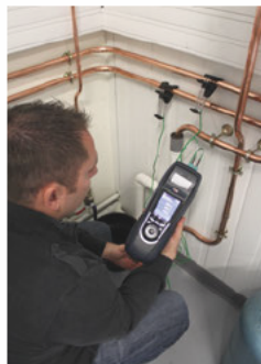
Pomiar ciepłej wody użytkowej
