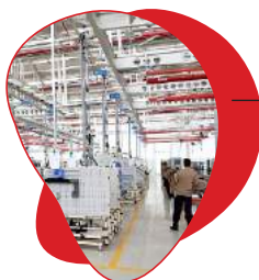
Hala testów zabezpieczeń
