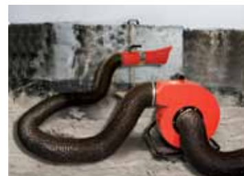
Wentylator przenośny osuszający zawilgoconą ścianę
