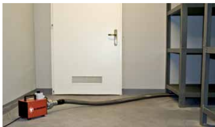
Suszenie trudno dostępnych miejsc przy użyciu przewodu elastycznego
