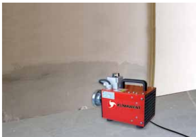
Suszenie zawilgoconych ścian
