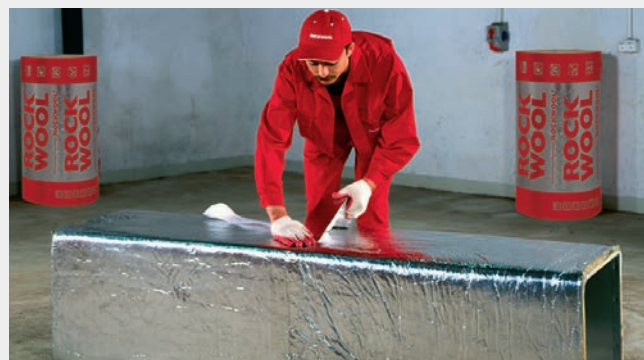
FOT. 415.8. Krok 4 – uszczelnienie taśmą aluminiową połączeń podłużnych i poprzecznych maty.
