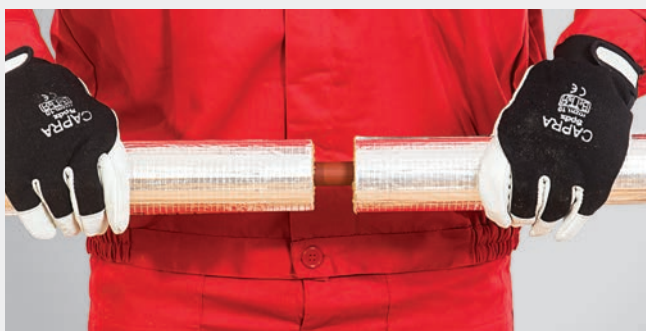
FOT. 412.3. Połączenie poprzeczne dwóch odcinków otulin.
