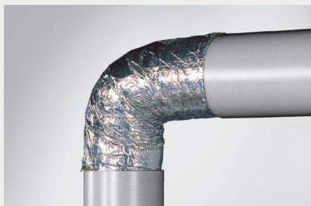
FOT. 414.4. Na odcinek prosty za kolaniem ponownie nakłada się otulinę TERMOROCK .
