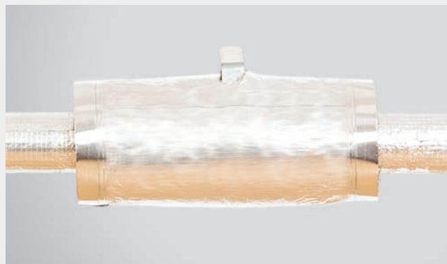
FOT. 412.23. Gotowa izolacja zaworu przy użyciu ALU LAMELLA MAT.
