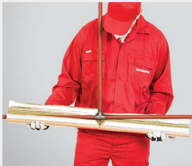
FOT. 412.17. Nałożenie dociętych elementów na odcinek poziomy i pionowy rury.
