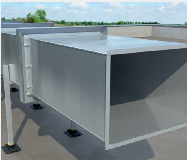
WIZ. 416.1. Mocowanie zetowników do powierzchni kanału.
