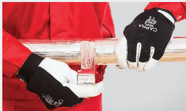
FOT. 412.4. Zabezpieczenie połączenia poprzecznego otulin samoprzylepną taśmą aluminiową.
