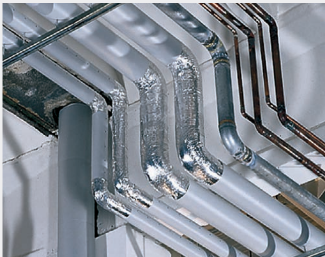
FOT. 414.1. Izolacja wykonana otulinami TERMOROCK i FLEXOROCK .
