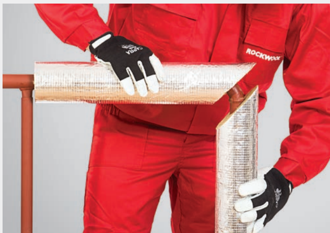
FOT. 412.7. Dopasowanie obu elementów izolacji kolana.
