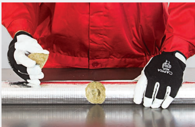
FOT. 412.15. Wycięcie klina 2 x 45° w odcinku prostym, w miejscu trójnika.
