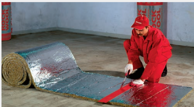
FOT. 415.5. Krok 1 – dokładne zwymiarowanie maty.
