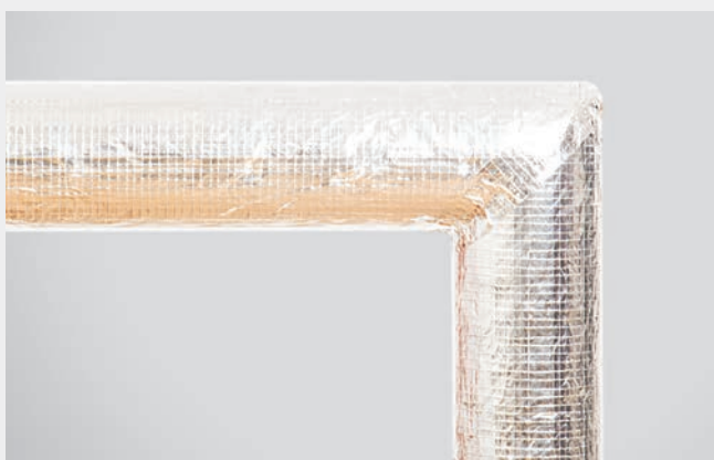
FOT. 412.9. Gotowa izolacja kolana z dwóch elementów otuliny ROCKWOOL 800.
