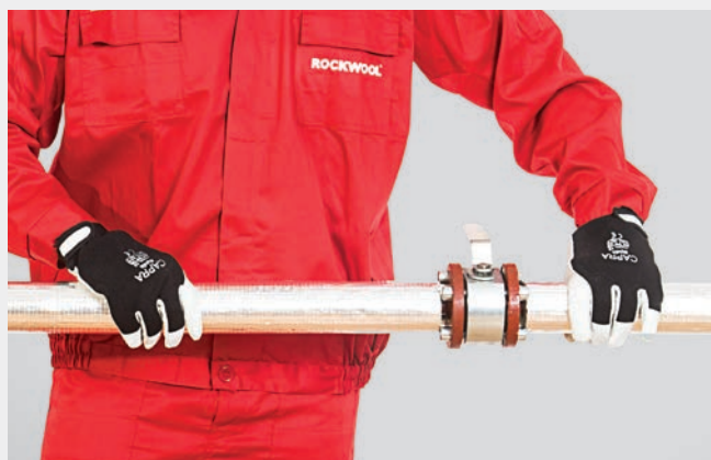
FOT. 412.20. Wstępne zaizolowanie odcinków prostych instalacji do zaworu odcinającego.
