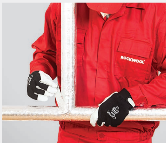
FOT. 412.19. Sklejenie styków izolacji taśmą aluminiową.
