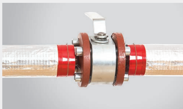
FOT. 412.25. Gotowa izolacja rurociągu przy zaworze, gdy nie ma możliwości izolacji zaworu.
