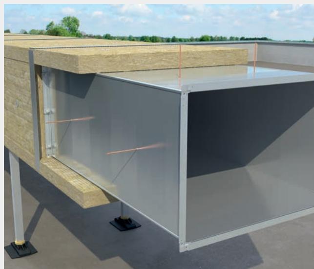
WIZ. 416.2. Układanie płyt ROCKTERM wraz z mocowaniem szpilkami zgrzewanymi do blachy kanału.
