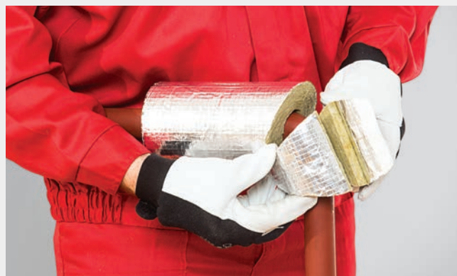
FOT. 412.11. Montaż jednego segmentu kolanowego.
