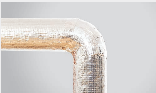
FOT. 412.14. Gotowe kolano zaizolowane otuliną ROCKWOOL 800 z jednym segmentem kolanowym.
