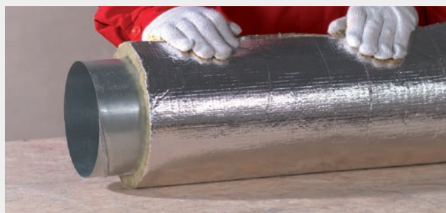
FOT. 415.2. Krok 2 – owinięcie kanału izolacją.
