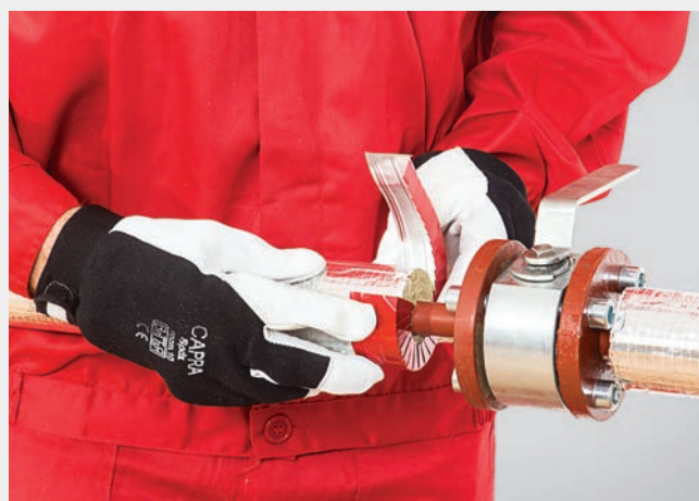
FOT. 412.24. Zabezpieczenie zakończenia odcinka prostego izolacji przy zaworze mankietem aluminiowym.
