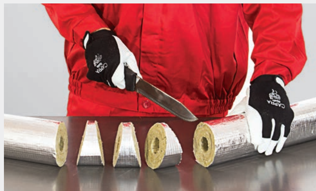
FOT. 412.10. Wycinanie segmentów kolanowych.
