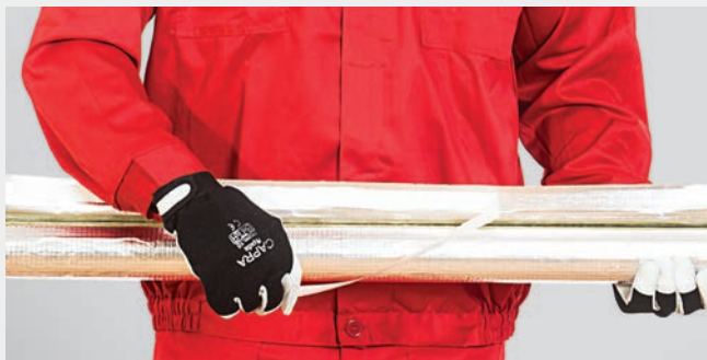
FOT. 412.2. Ściągnięcie taśmy PE z zakładki samoprzylepnej.
