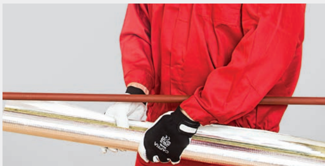
FOT. 412.1. Nałożenie otuliny na odcinek prosty rurociągu.
