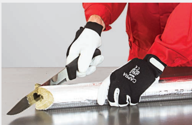
FOT. 412.16. Wycięcie klina 2 x 45° w odcinku izolującym odgałęzienie rurociągu.
