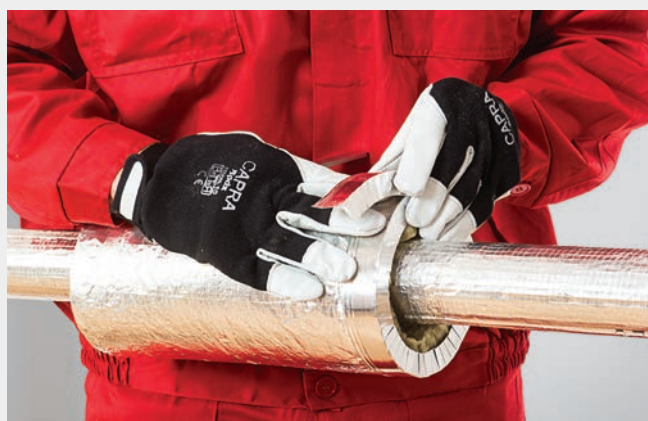
FOT. 412.22. Zabezpieczenie zakończenia izolacji mankietem aluminiowym.
