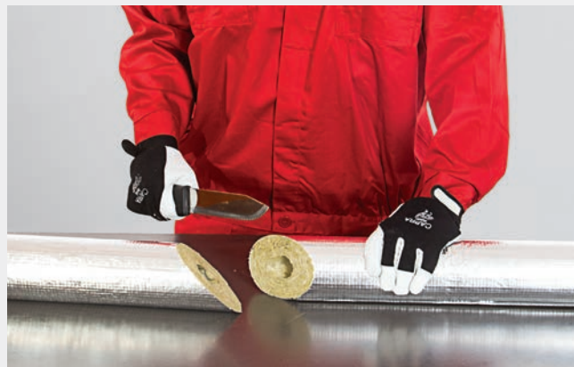
FOT. 412.5. Rozcięcie otuliny pod kątem 45° na dwa elementy.
