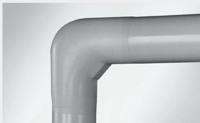
FOT. 414.5. Na zaizolowane kolano należy nałożyć osłonę PCV, sklejając wszystkie połączenia taśmą PCV.
