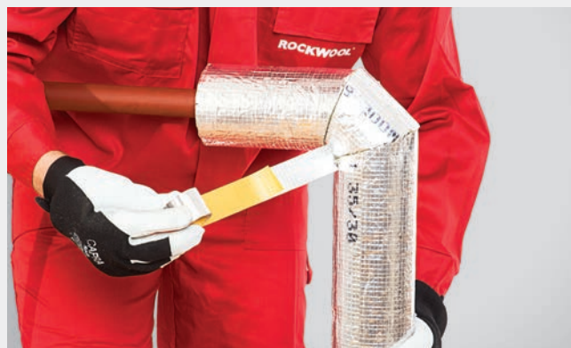
FOT. 412.13. Sklejenie połączeń poprzecznych taśmą aluminiową.
