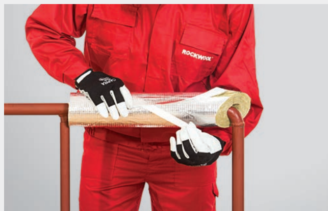
FOT. 412.6. Sklejenie połączenia wzdłużnego zakładką samoprzylepną.
